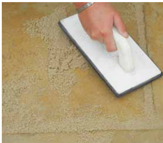
ukázka použití spárovací hmoty SAKRET PF-1
